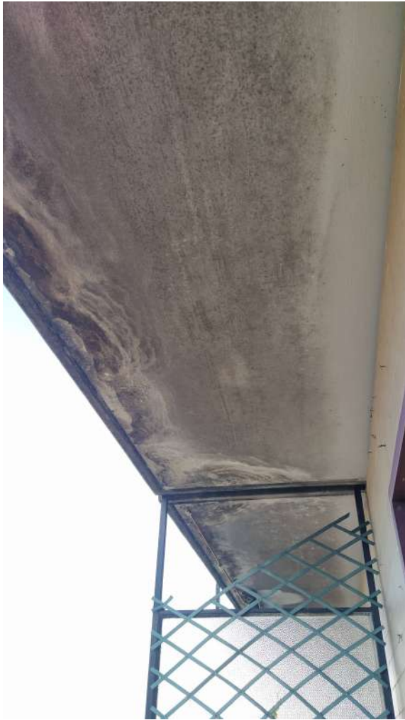
GRONDA AMMALORATA
